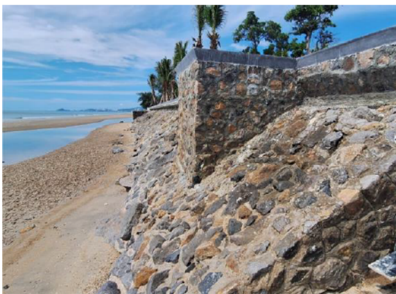
รูปที่ 2-15 หินยาแนวตลอดแนวเชื่อมกันดิน
