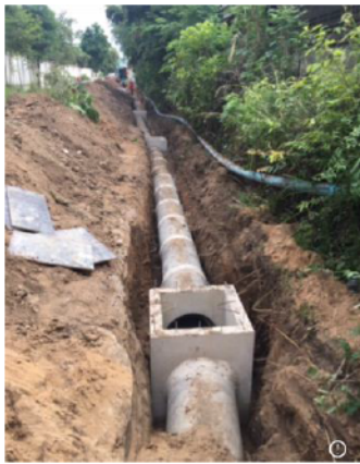
รูปที่ 2-21 แนวท่อแรงดันเชื่อมต่อกับท่อระบายน้ำสาธารณะประโยชน์
