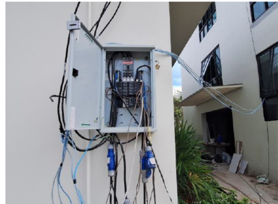
รูปที่ 2-14 แผงควบคุมและสวิตช์ตัดวงจรไฟฟ้า
